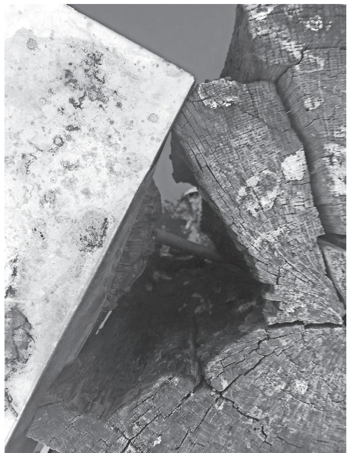
Von innen ausgebrannter Schiffsanlegepfahl
