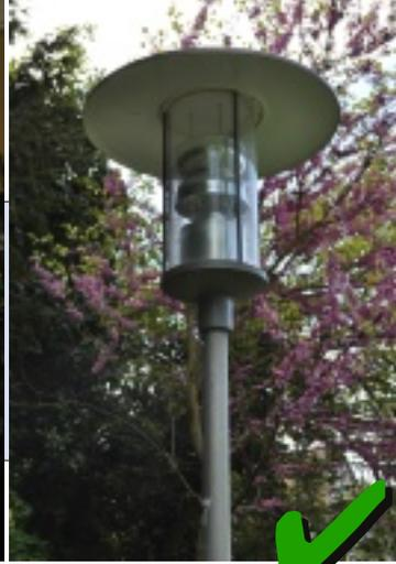
Kugelleuchten streuen das abgegebene Licht unspezifisch in alle Richtungen. Mittels einer eingesetzten Blende und einer Abdeckung wird eine gezielte Lichtlenkung nach unten erzielt.
