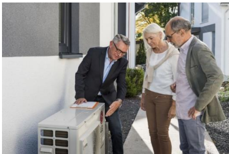
Wärmepumpen heizen klimafreundlich. Foto: Zukunft Altbau
